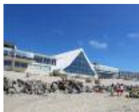
Le groupe Accor a décidé d'engager des travaux de rénovation de la Thalassothérapie, en 2017
